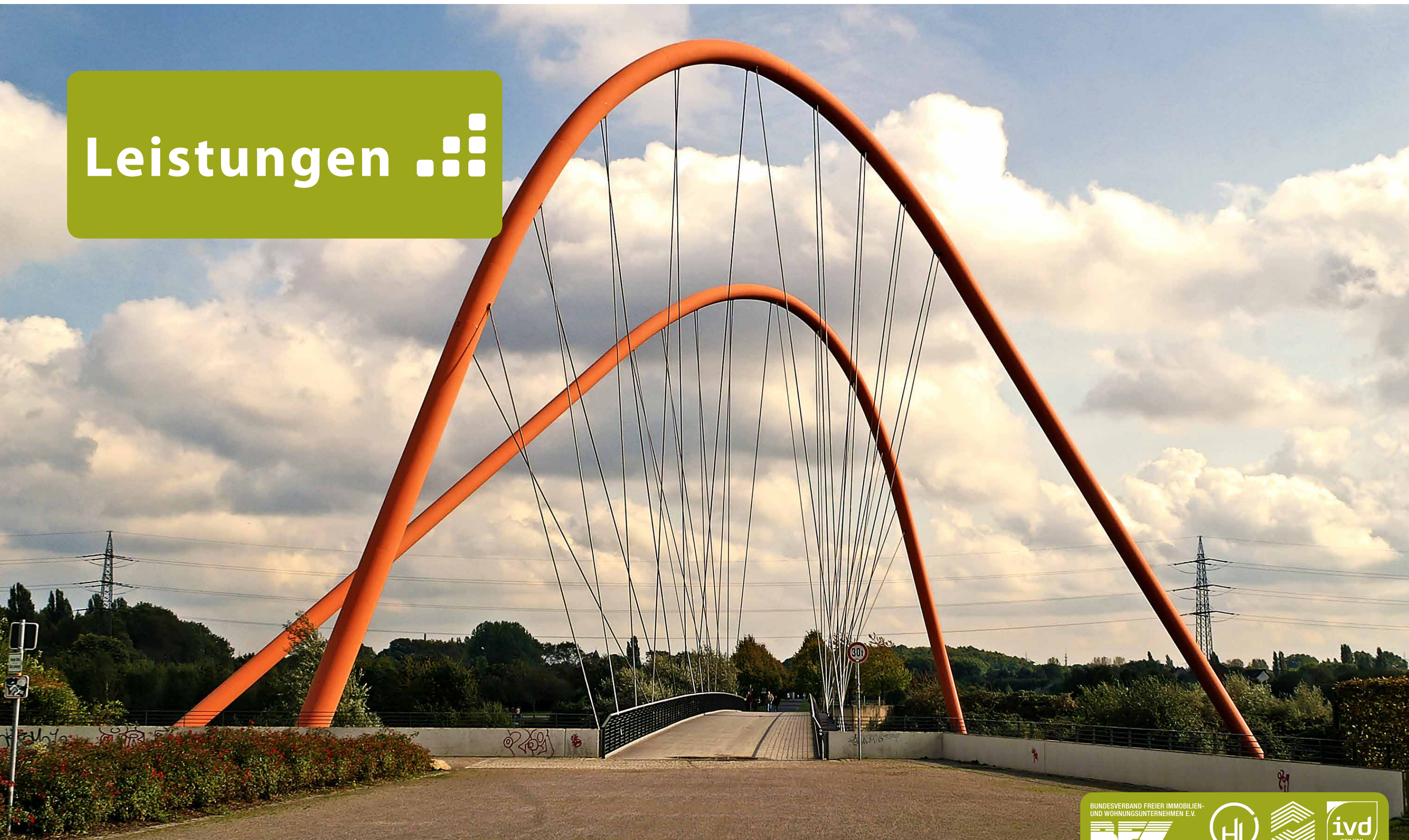
„Doppelbogenbrücke“ - Zeche Nordstern, Gelsenkirchen
